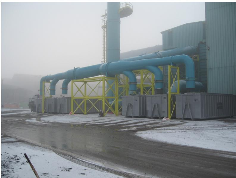
**Abbildung 18: Beispiel für sechs parallel geschaltete AIRCON-Einheiten**
