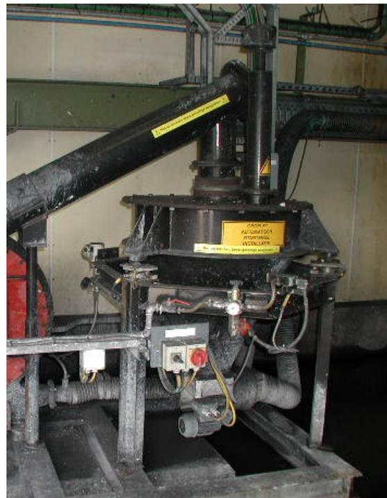
**Abb. 19: Einrichtung zum Einblasen von Adsorbentien: links: Silo und Förderschnecke; rechts: Förderschnecke und Einblassignsystem**
